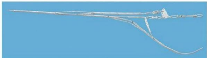
图10 安全备份线夹最终安装完成示意图
